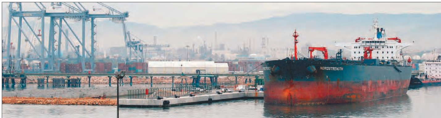
El Port de Tarragona está llevando a cabo las obras para ampliar la terminal de contenedores del muelle Andalucía. En los últimos días ha ejecutado nuevos trabajos. FOTO: DT
